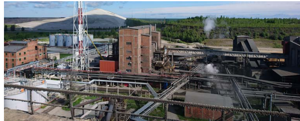
Joonis 10: TSK-500 põlevkiviõli tootmise tehas
